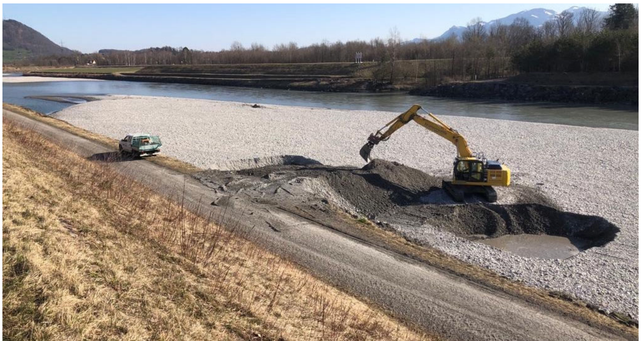
Abbildung 3 Geschiebeentnahme am Alpenrhein (Foto: Rheinunternehmen).
