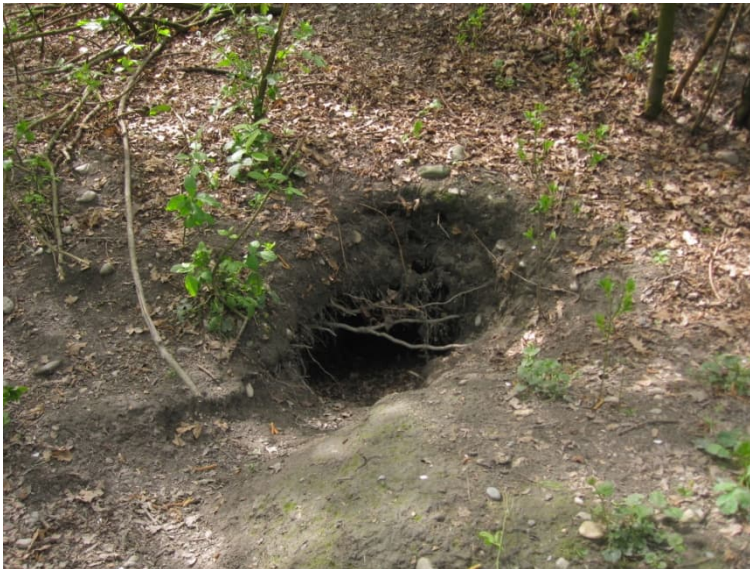
Dachsbau am Rheindamm
